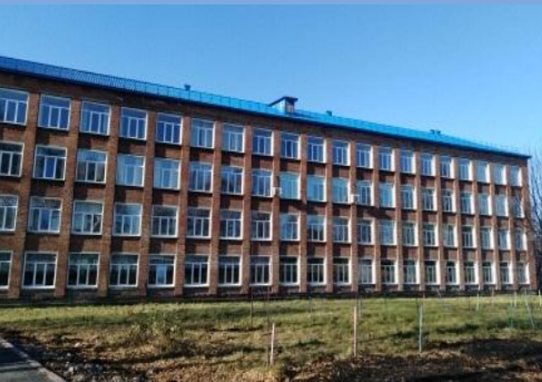
Капитальный ремонт крыши
